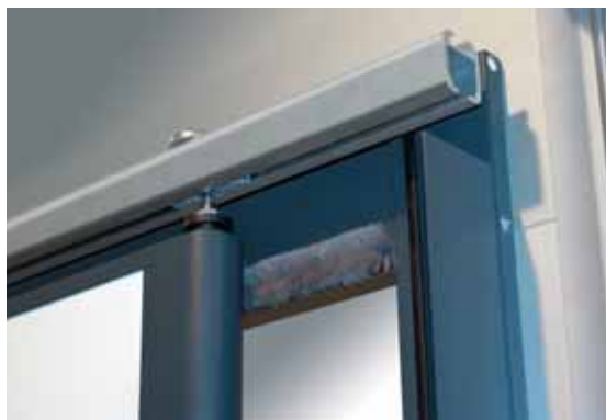
Précadre aluminium laqué + joint brosse et joint caoutchouc.
