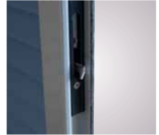
Point de fermeture central avec possibilité de réglage
