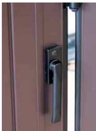
Poignée de déverrouillage pour les 3-4 vantaux + joint anti-pince doigt étanche
