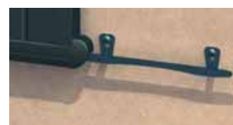
Règlette support en partie basse pour porte-fenêtre avec motorisation
